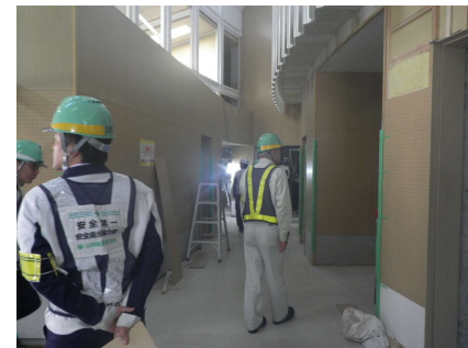
【久御山町全世代・全員活躍まちづくり センター建築工事】
