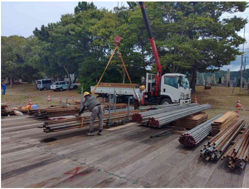
【YTV ショー用水上橋架設工事(令和8年度)】
