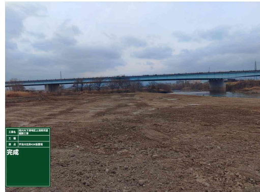
【桂川大下津地区上流他河道掘削工事】
