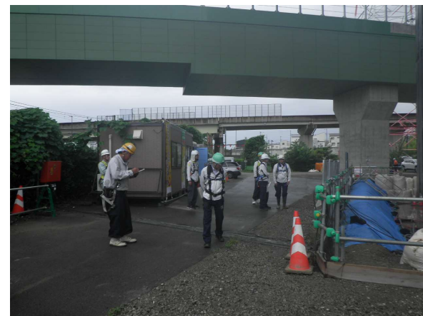
【新名神城陽第一高架橋（下部工）拡幅工事】
