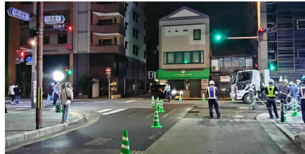
【東／既設溶接鋼管対策5 舗装本復旧工事】
