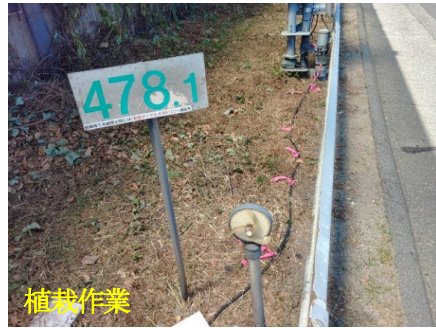
【令和7年度京都地区保全工事(その1)】
