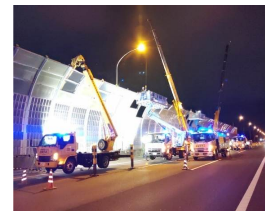
【名神集中工事(透光板取替作業)】
