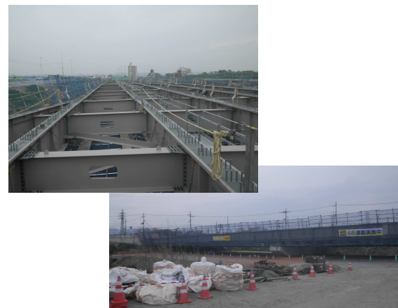
【（総合評価）宮前橋整備（その14）工事】
