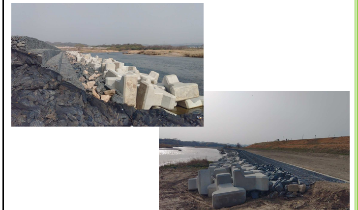
【木津川上粕地区堤防強化他工事】
