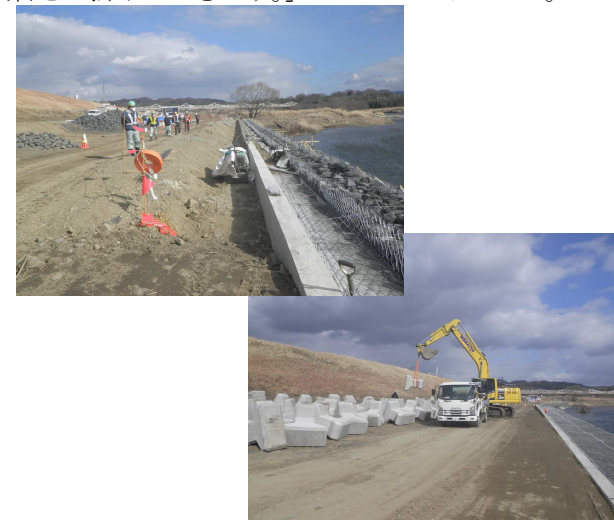
【木津川上粕地区堤防強化他工事】
