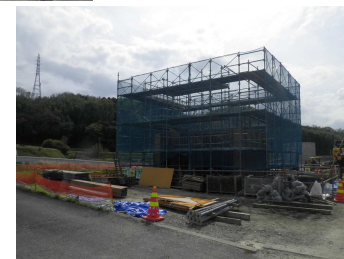
【精華拡幅柵5号線橋梁下部工事】
